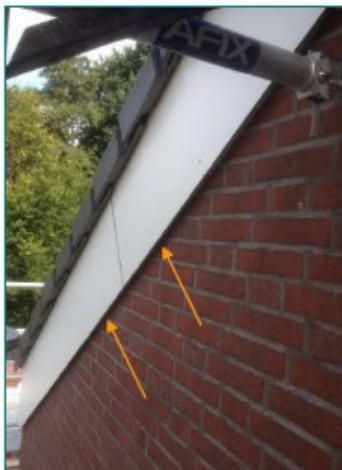
Figuur 6: Kopgevel met aangebrachte trespa boeibord. De pijlen geven enkele invliegopeningen voor vleermuizen weer in verschillende compartimenten.
