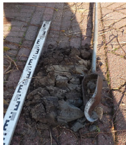
Afbeelding 9: Boring vanuit de profielkuil
