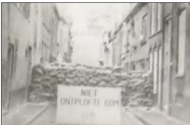
Figuur 40: Voorbeeld afzetting blindganger met waarschuwingsborden 46
