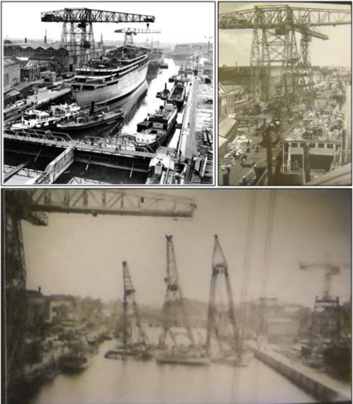
Figuur 51: Situatie scheepsbouwwerf (vergelijkbaar) WOII - Links boven ligt de Willen Ruys nog voor de kade en zien we links en rechts de verharde kades. Rechts geeft een beeld van de noordelijke kade en onder een overzicht van beide kades.
