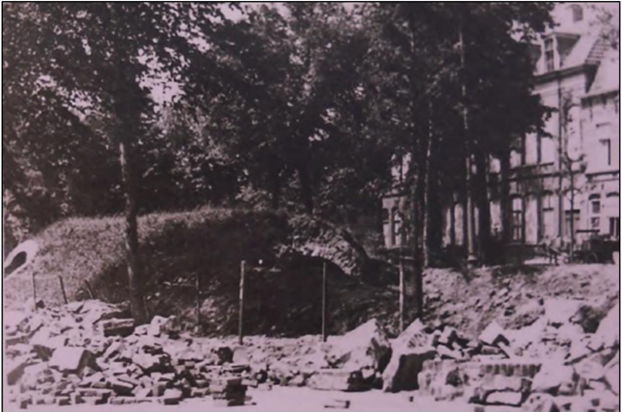
Figuur 13: Op 30 april 1942 getroffen schuilkelder in de Aagje Dekenstraat
