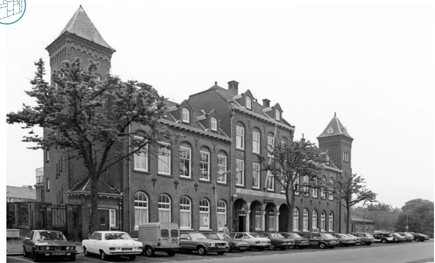
Het voormalige Postkantoor
