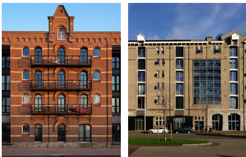
Referentie: afwijkende materialisatie van de balkons (staal vs baksteen) of inpandige buitenruimte
