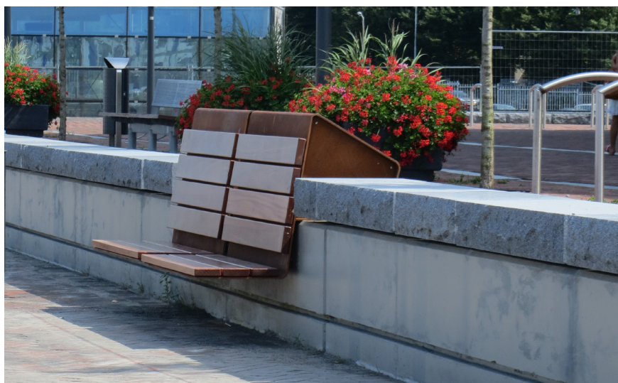
Bestaande keermuur, met eigentijds vormgegeven zitelementen
