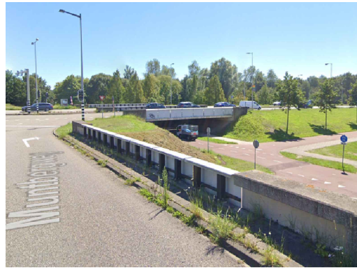
2: Viaduct Meibergdreef met talud
