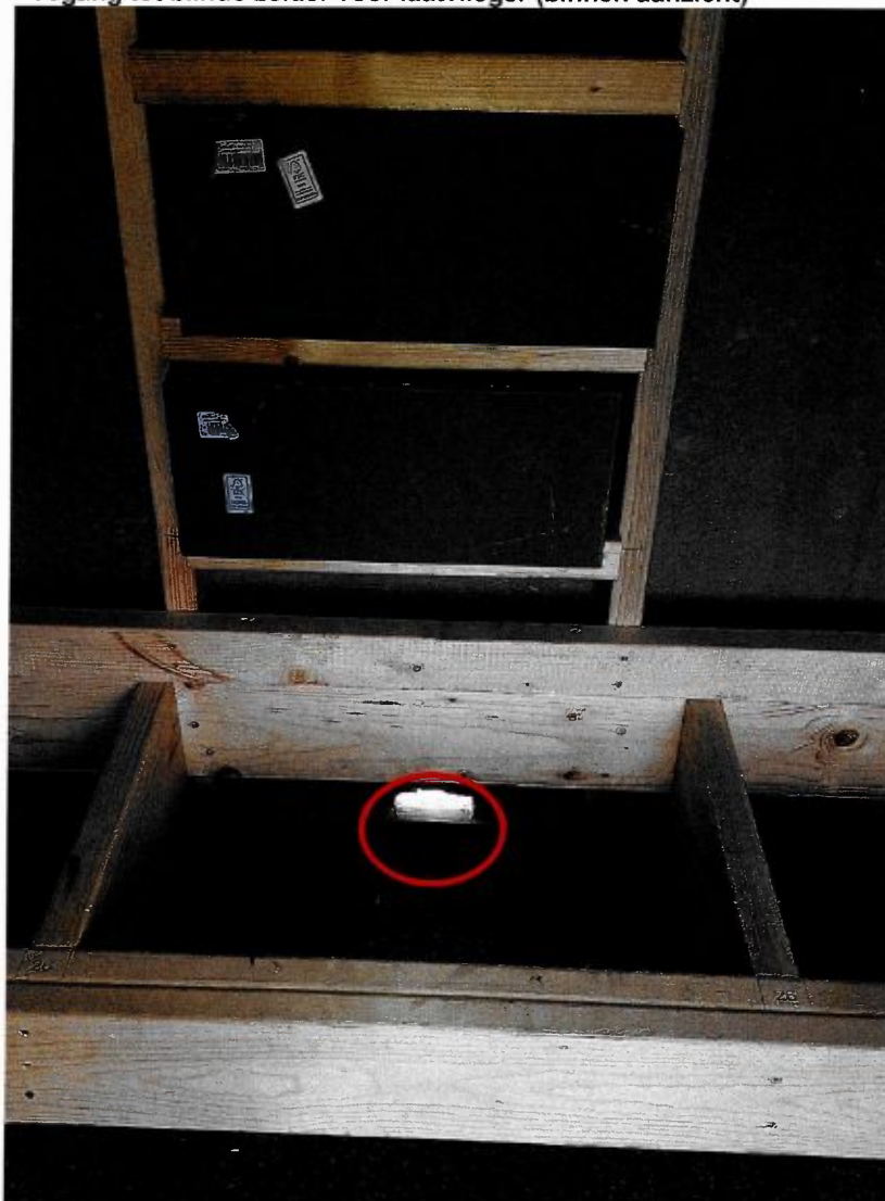
Toegang tot blinde zolder voor laatvlieger (binnen aanzicht)
