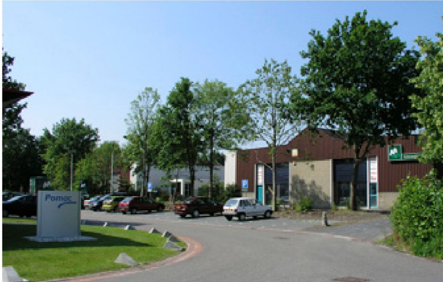
Foto 91: Industriebouwwing tegen de Tolbertervaart
