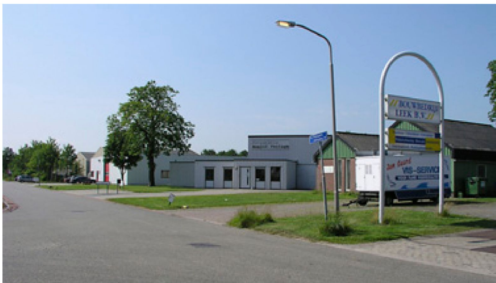
Foto 90: Gesloten gevels aan het Feithspark
