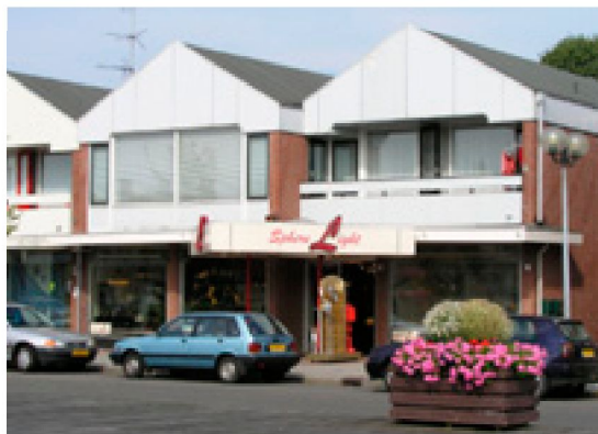
Foto 117: Voorbeeld reclame op luifel
