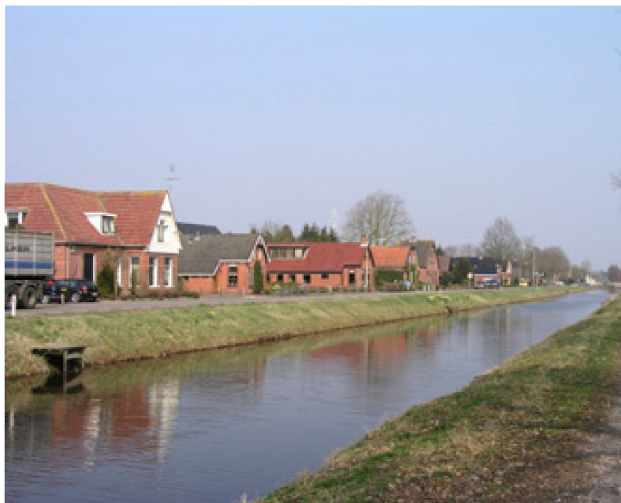
Foto 55: Diepswal tegen industrieterrein aan
