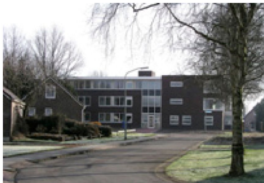
Foto 126: Wozoco Zevenhuizen (westzijde)
