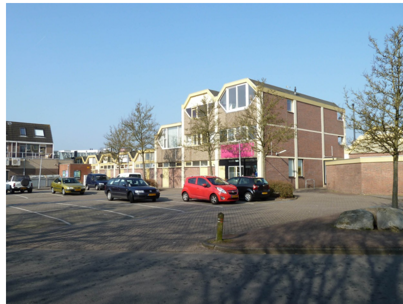
Boven: Achterzijde bebouwing langs parkeerterrein ten zuidoosten van de Liekeblom
