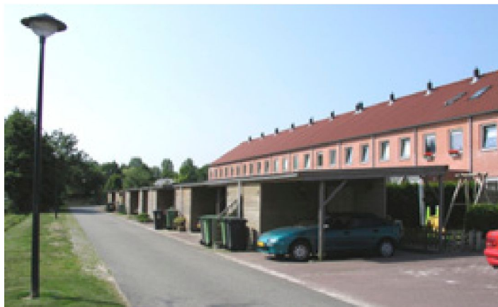
Foto 77: Vormgeving perceelsafsluitende bergingen en carports
