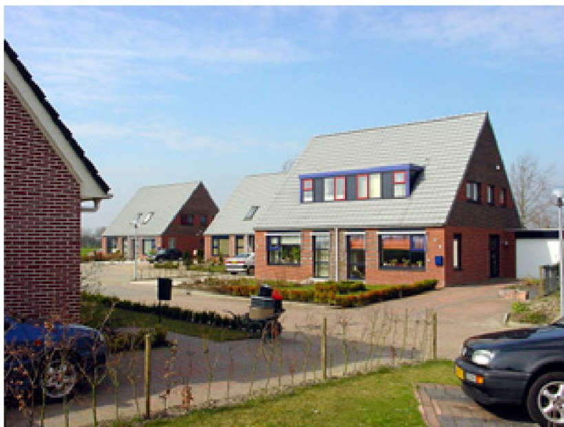
Foto 21: Nieuwbouw De Klap
