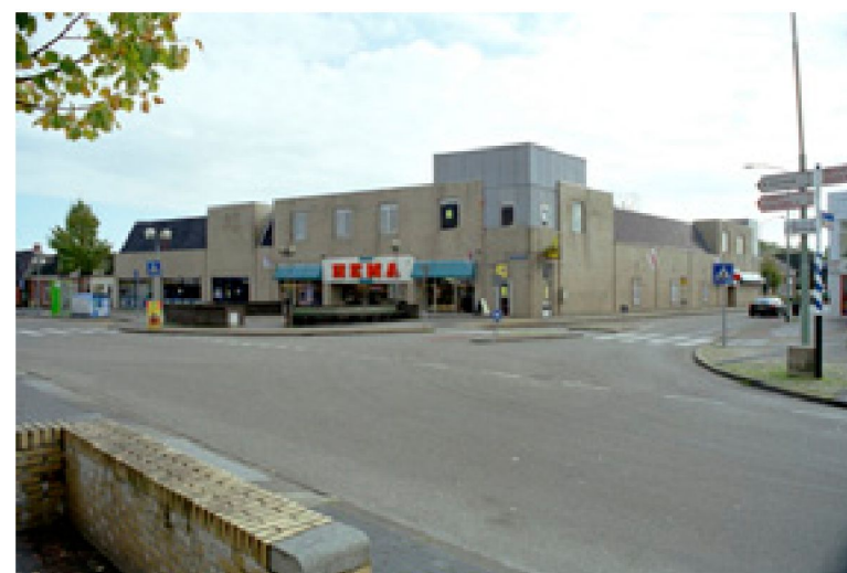
Foto 33: Hoek de Dam/Piepk
