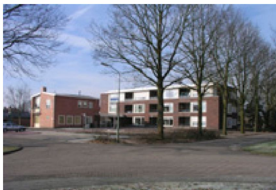
Foto 125: Wozoco Zevenhuizen (oostzijde)
