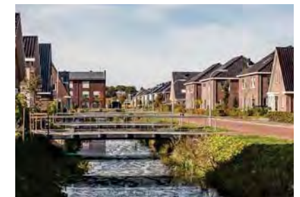
gerealiseerde erftoegangsbruggen fase 1
