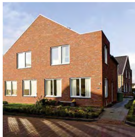
2-onder-1-kapwoning met eenvoudige uitbouw in gelijke materialisering als basisvolume
