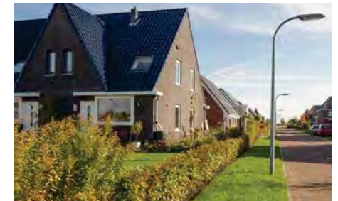
geslaagd voorbeeld gerealiseerde 2e kopgevel
