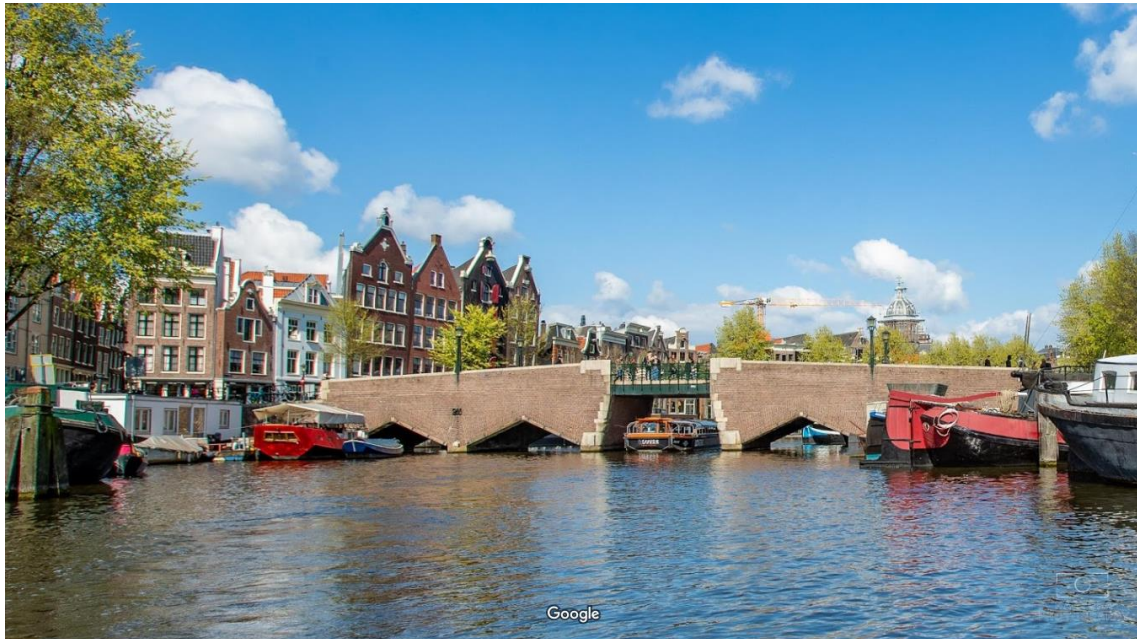
Figuur 6. Oostelijk aanzicht brug 283, de Waalseilandbrug
