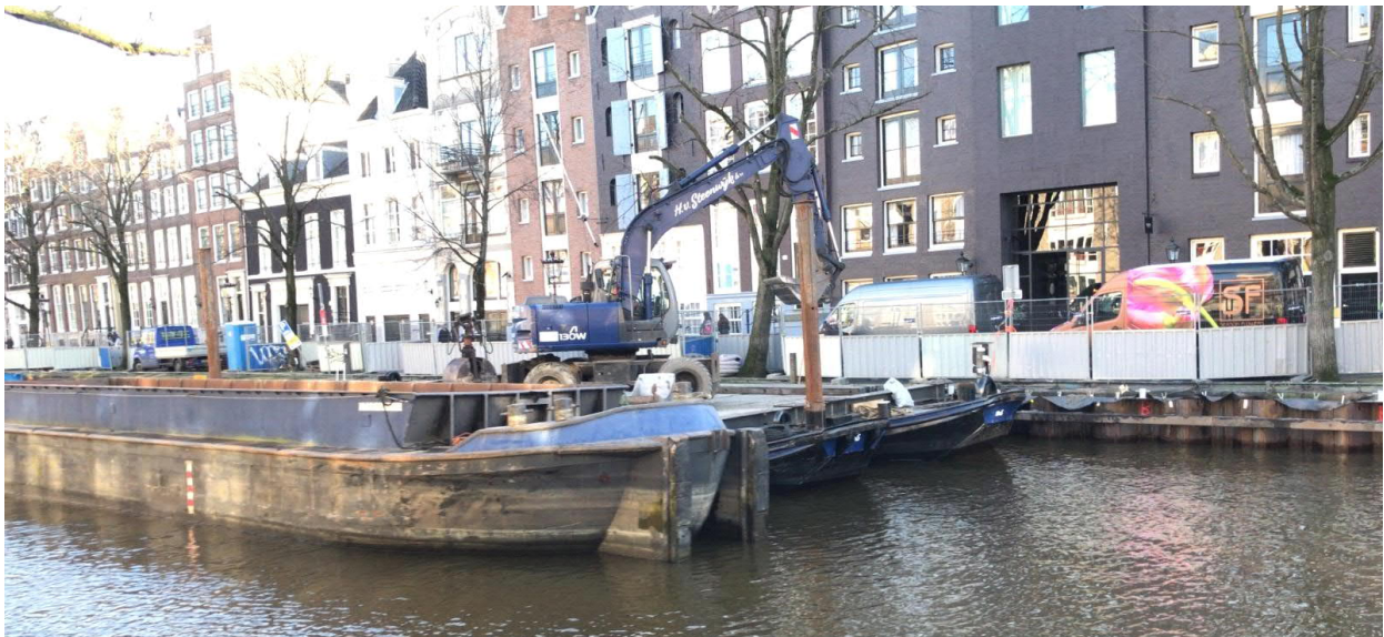
Figuur 12 Steenwijk 4 & Steenwijk 6 met daarop een 15 tons mobiele kraan met sorteerknipper en duwbak zand ernaast
