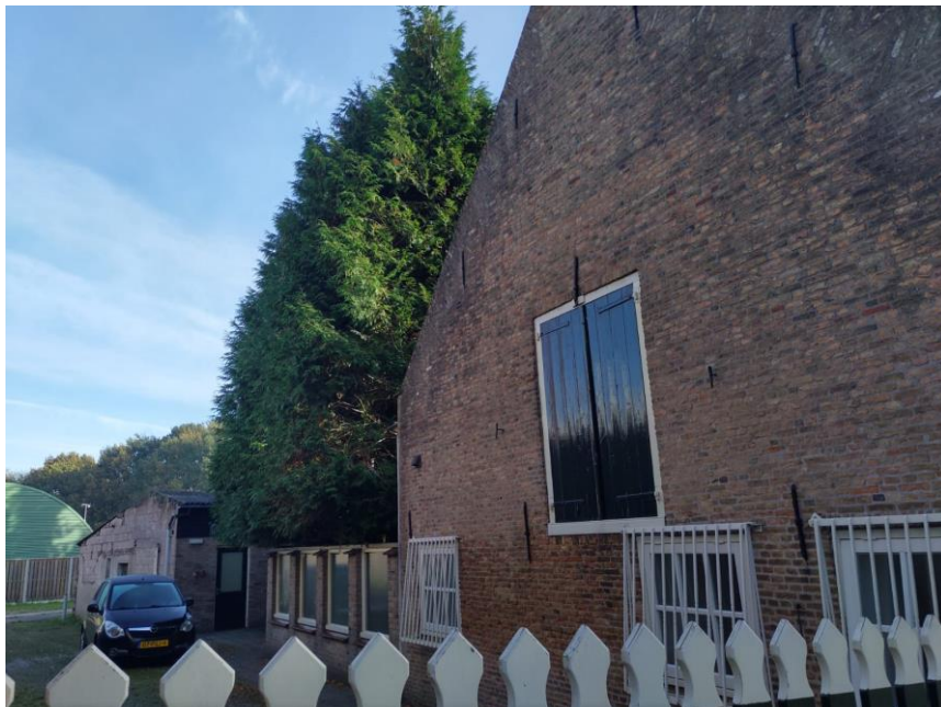
Foto van met name cluster 1 gezien vanuit de inrit aan zuidzijde.
