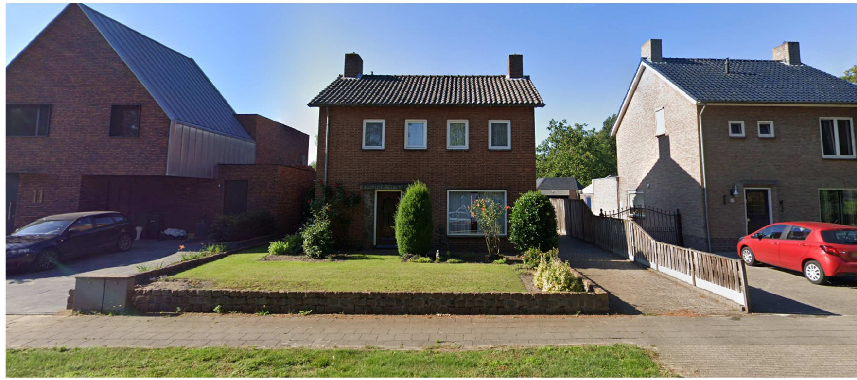
Foto bestaand straatbeeld
