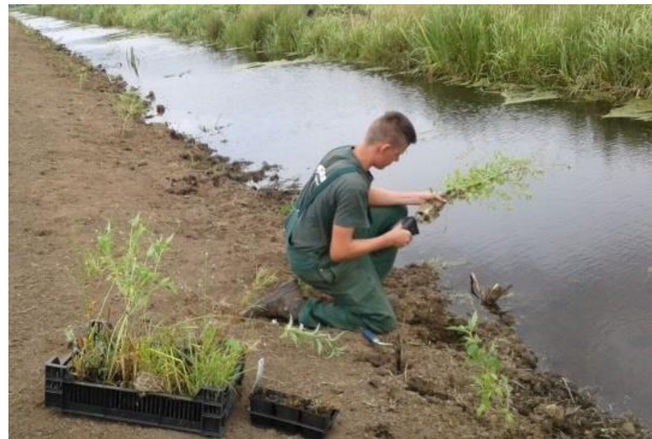
3-11 Natuur vriendelijke oevers - aanleg
