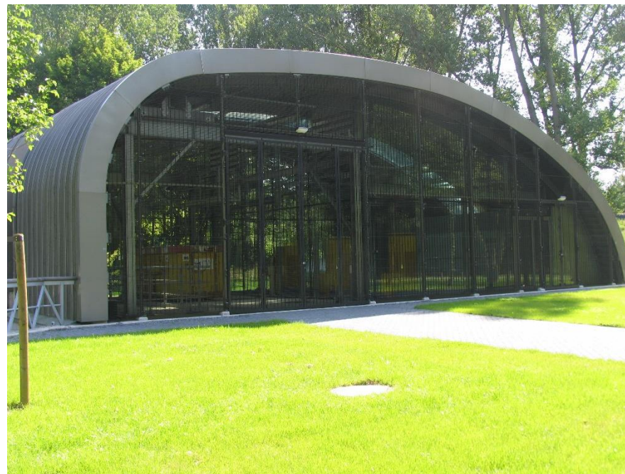
3-6 Gemaal in Lansingerland Bleiswijk
