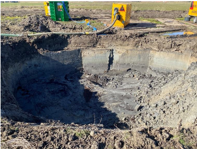
Foto 28: Ontgraving oliespot (4)
