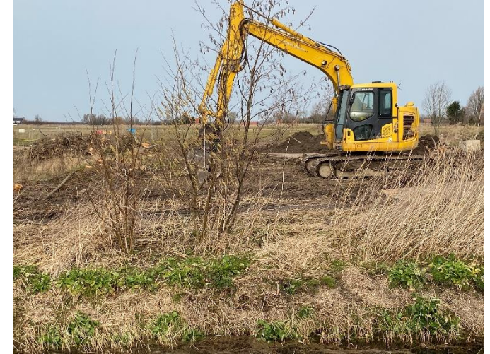
Foto 21: Graafwerkzaamheden tbv asbestverontreiniging
