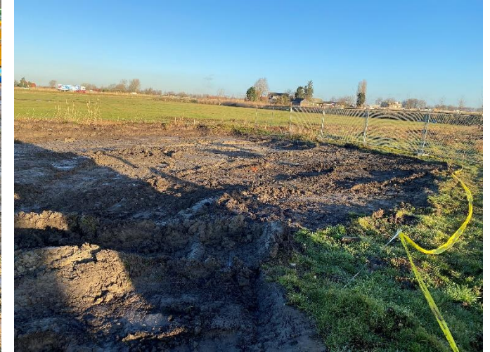
Foto 33: Overzicht afgraving asbest 2
