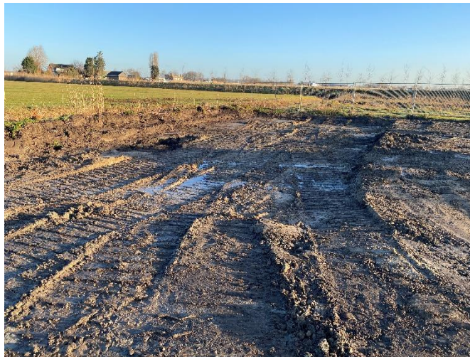
Foto 35: Overzicht afgraving asbest en afvlakkende wanden aan noordoostzijde
