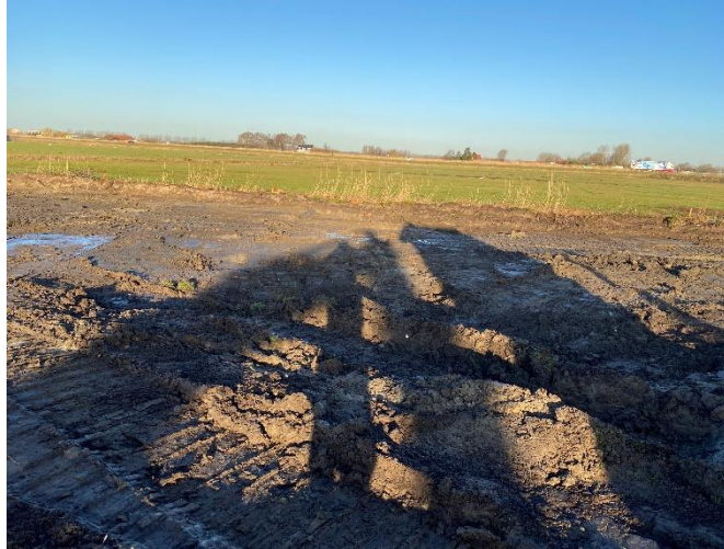
Foto 38: Overzicht ontgraving asbest 1
