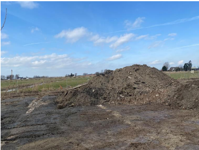
Foto 16: Depot asbest en puin (2)
