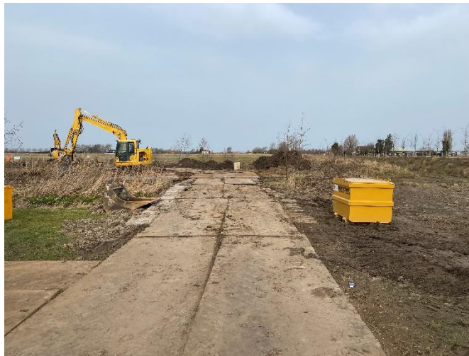
Foto 41: Rijplaten buiten sanering tbv graafmachines
