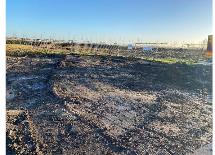
Foto 39: Overzicht ontgraving asbest 4
