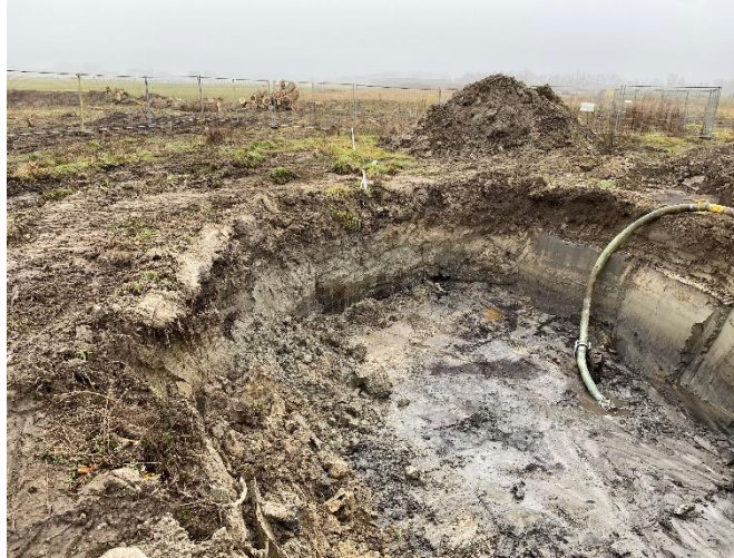
Foto 14: Bemaling grondwater oliespot (2)
