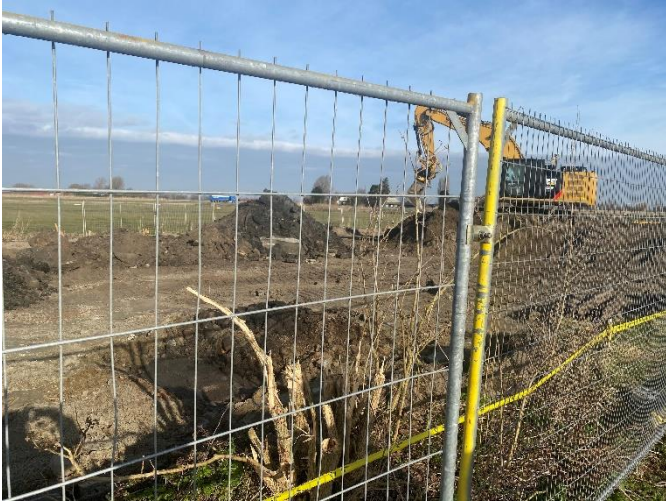
Foto 25: Ontgraving en depotvorming asbestverontreiniging
