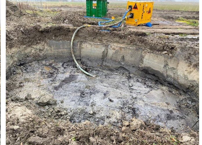
Foto 15: Bemaling grondwater oliespot
