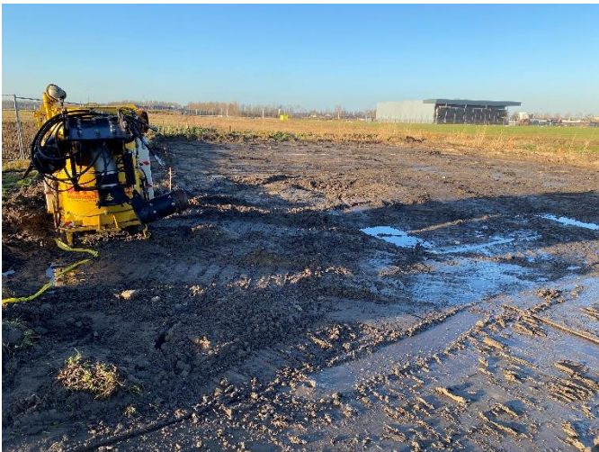
Foto 34: Overzicht afgraving asbest 3
