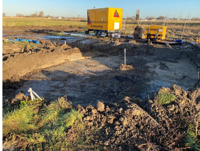
Foto 26: Ontgraving oliespot (2)
