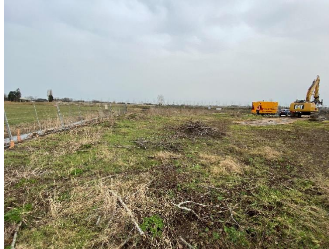
Foto 8: Asbest locatie voor graafwerkzaamheden
