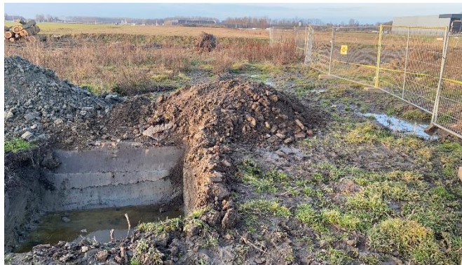
Foto 5: Afgraving oliespot
