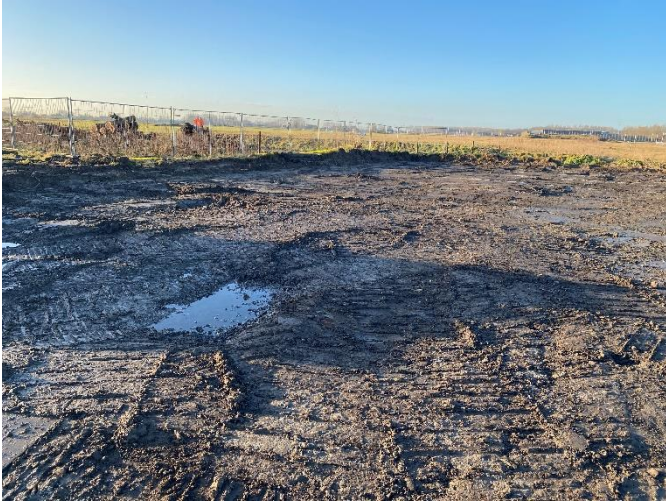
Foto 37: Overzicht ontgraving asbest (2)
