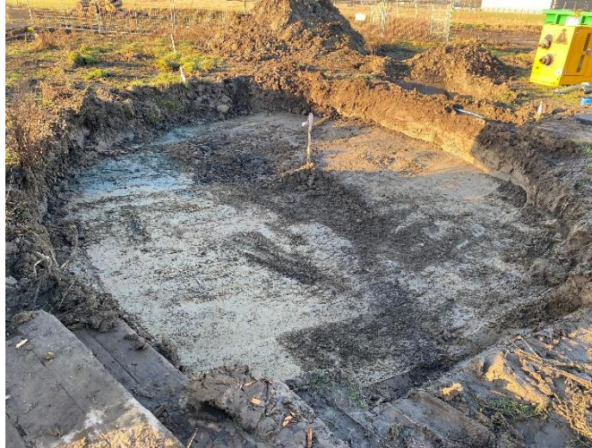
Foto 32: Ontgraving oliespot
