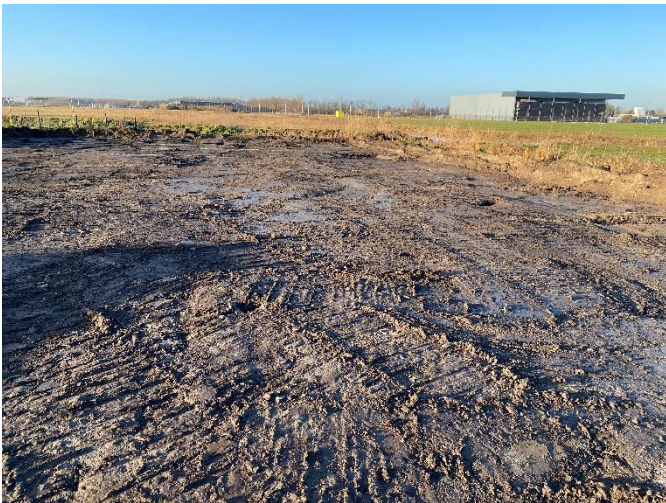
Foto 40: Overzicht ontgraving asbest
