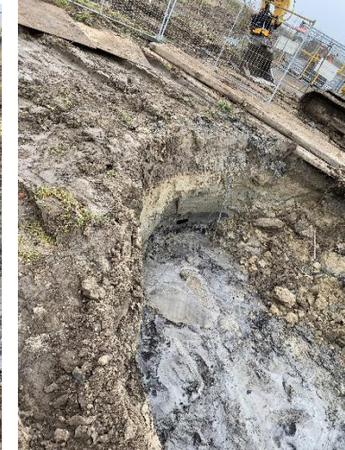
Foto 30: Ontgraving oliespot en afzetting hekwerk
