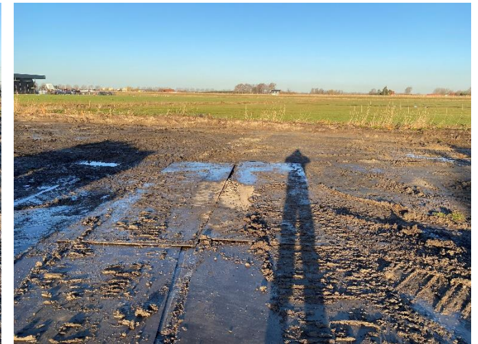
Foto 36: Overzicht afgraving asbest met beperkingen uitkeuring vanwege rijplaten
