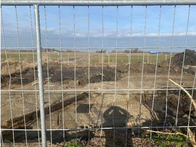
Foto 7: Afzetting hekwerk asbest ontgraving
