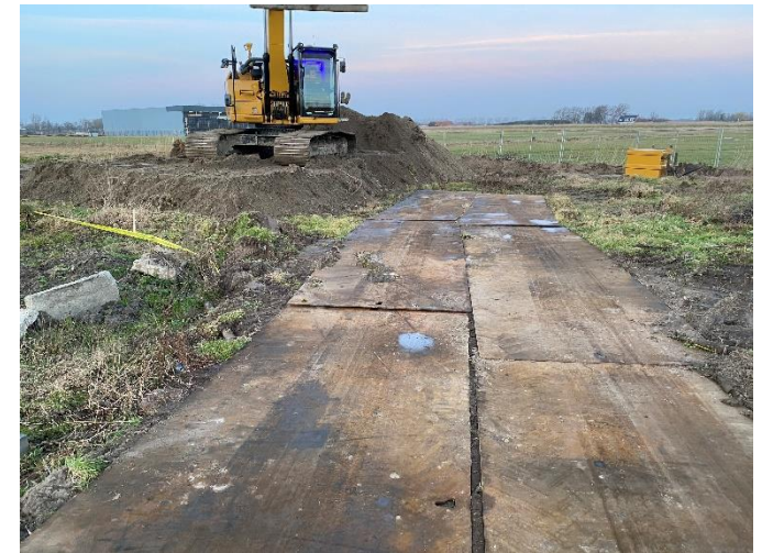
Foto 42: Rijplaten tbv graafmachines
