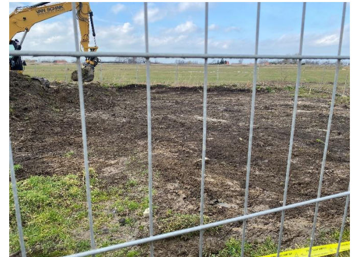
Foto 6: Afgraving toplaag asbestverontreiniging
