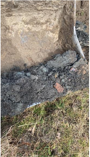
Foto 49: Zoom in afgraving asbest met bijmengingen
