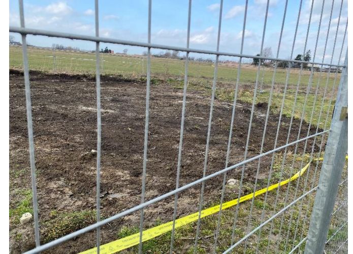
Foto 3: Afgraving asbest en afzetting met lint
