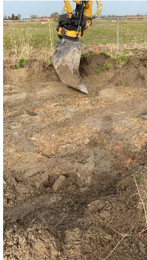
Foto 2: Afgraven asbest en aantreffen puinlaag
