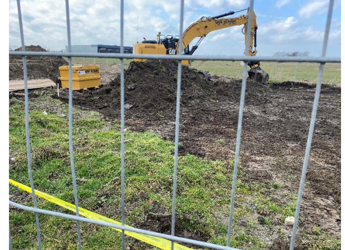
Foto 45: Start ontgraving asbestverontreiniging
