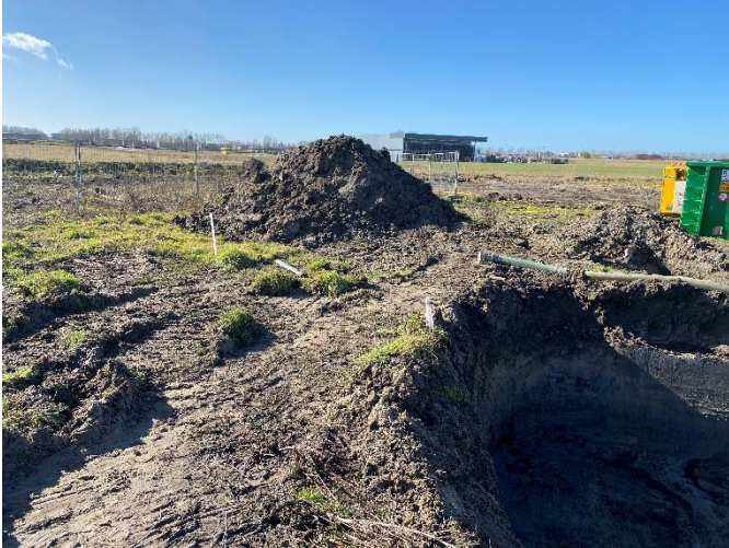
Foto 19: depotvorming oliespot
