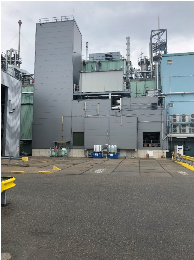
Figure B 7: Aanzicht Westzijde Gevel FEP Copolymer gebouw
