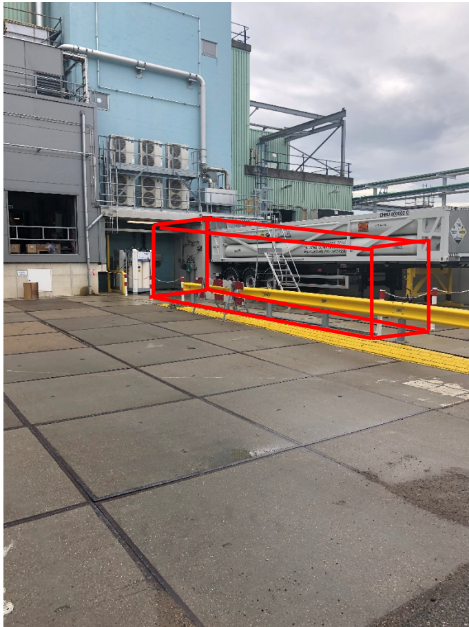
Figuur 3-2: Overzicht Locatie Zuurstof Generatie Unit
