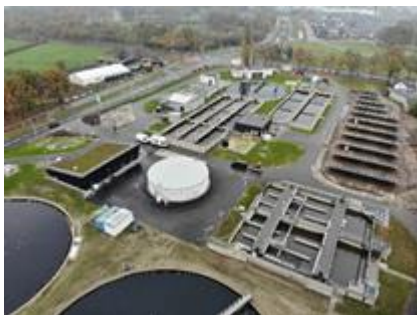
Luchtfoto van de rwzi Vissedijk in Almelo, die in 2020 is gerenoveerd
