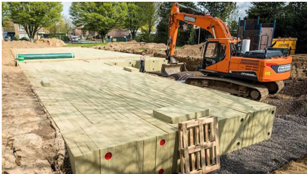
Figuur 0-1: Voorbeeld van de aanleg van Rockflow in de gemeente Maasgouw.
