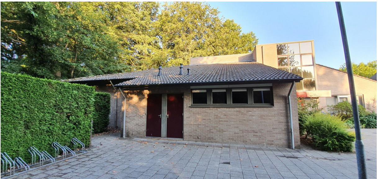
Oostzijde van het Kerkheem met een deel van het dakpannendak. Foto: K. de Vries | Ecoresult B.V.
