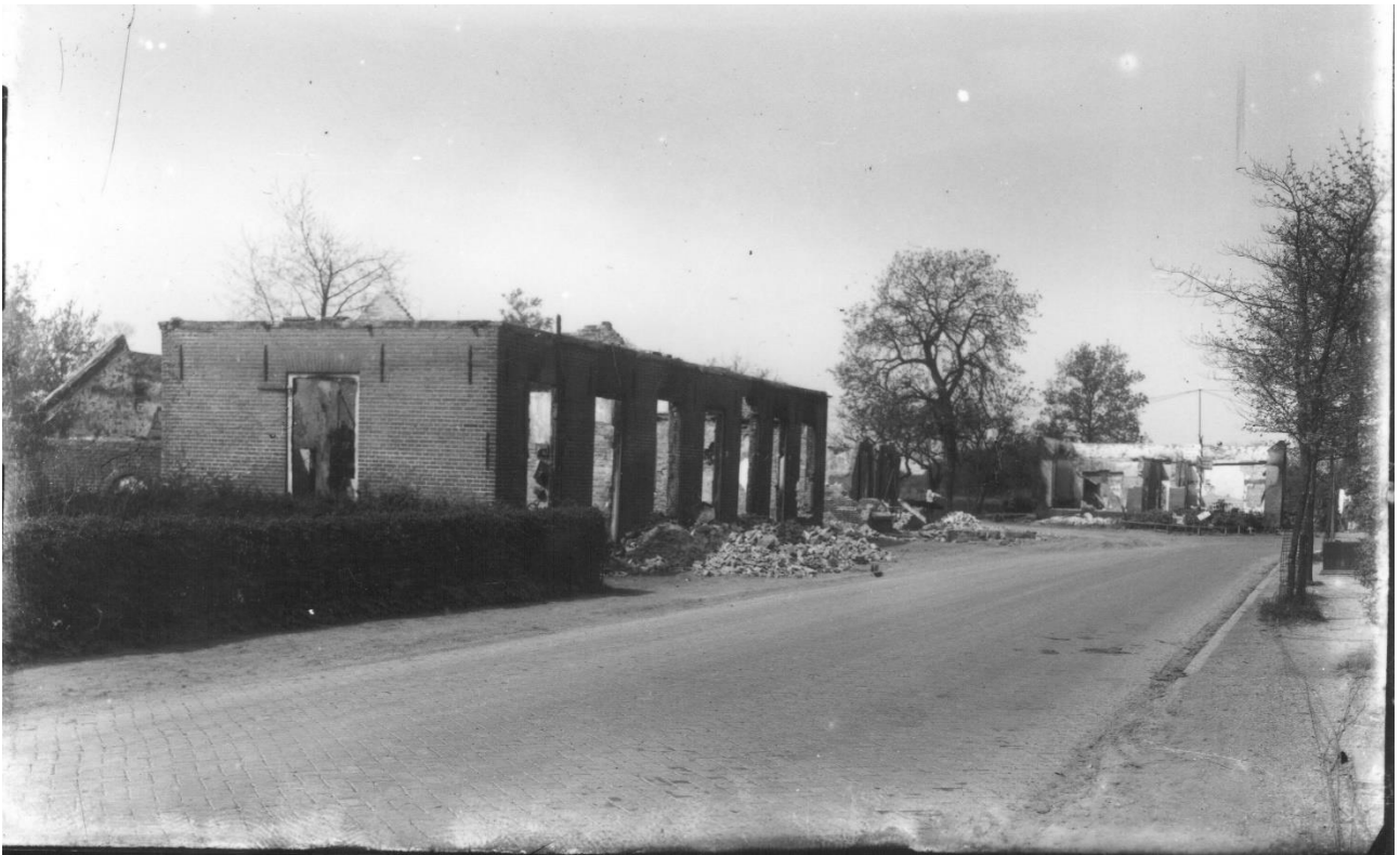
Figuur 11: Schade woningen einde Kerkstraat
