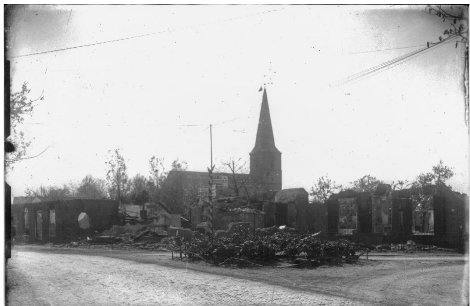
Figuur 10: Schade woningen met de Hervormde kerk op de achtergrond
