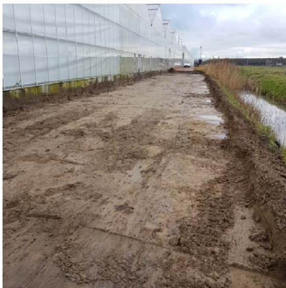
Foto 3: Ontgraving locatie gereed
