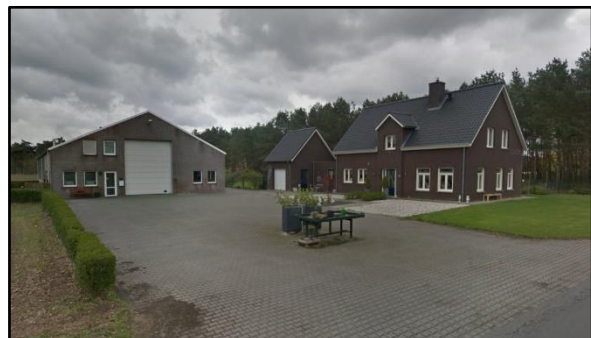
Afbeelding 10. Loods met bedrijfswoning ten westen van projectlocatie
