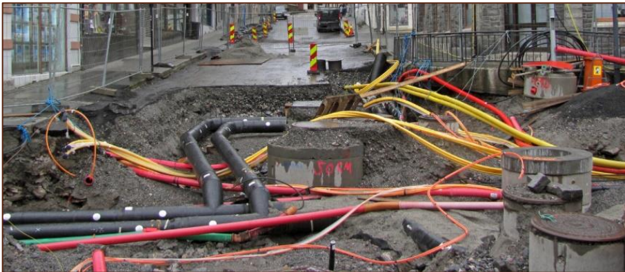
Figuur 4.3: Het wordt druk in de openbare ruimte met kabels en leidingen (bron: drinkwaterplatform.nl)
