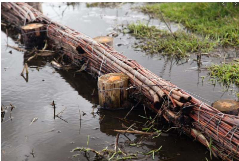
Voorbeeld wilgentenen beschoeiing met dubbele palenrij
