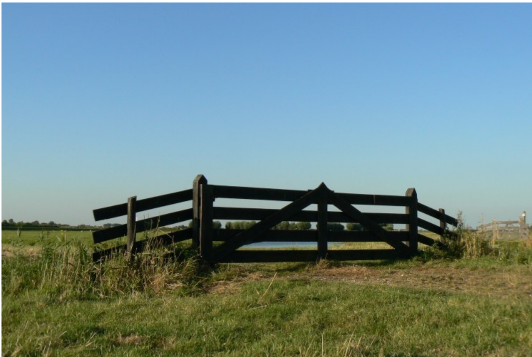
Afbeelding 5.6 Voorbeeld van houten boerenlandhek met vleugels (foto Arthur Schaafsma)
