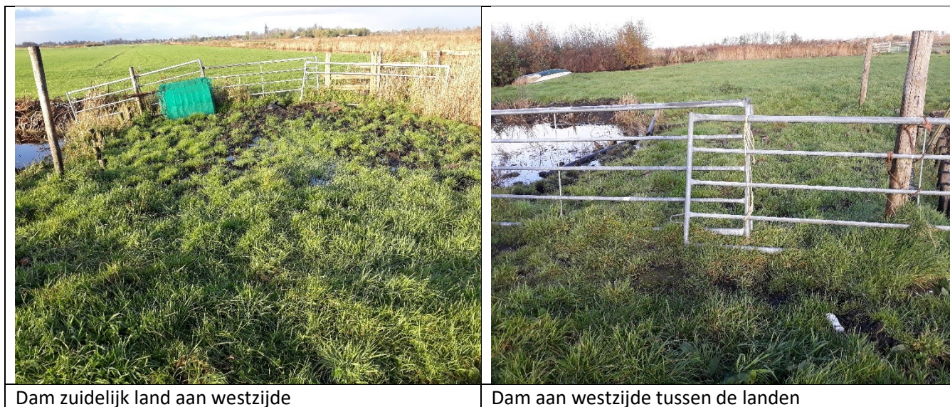
Afbeelding 2.4 foto's van dammen aan de westzijde
