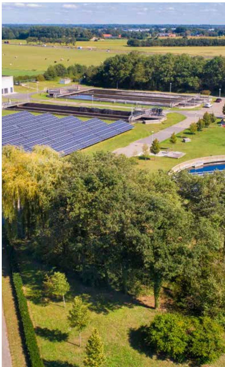
Zonneveld riolwaterzuivering Haaksbergen
