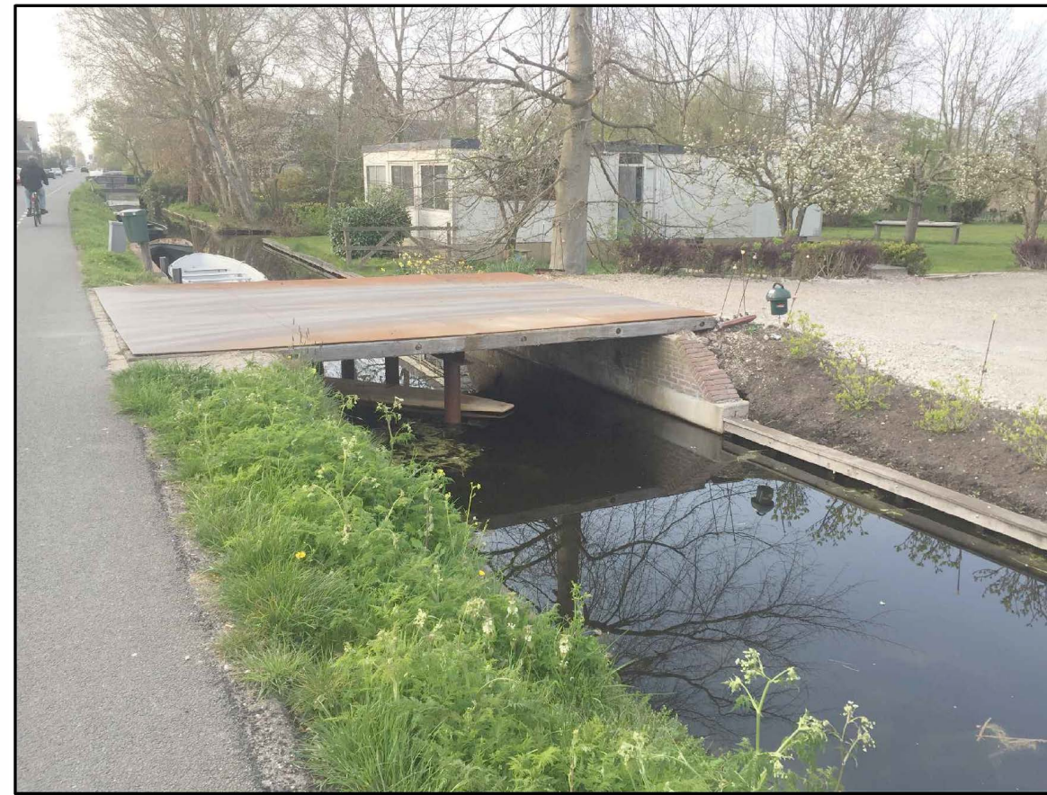
Foto bestaande noodbrug
