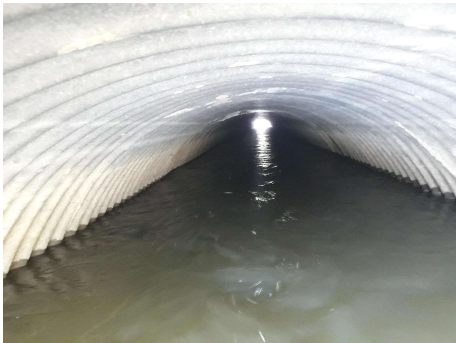
Figuur 4.3: binnenzijde duiker vanaf de noordzijde
