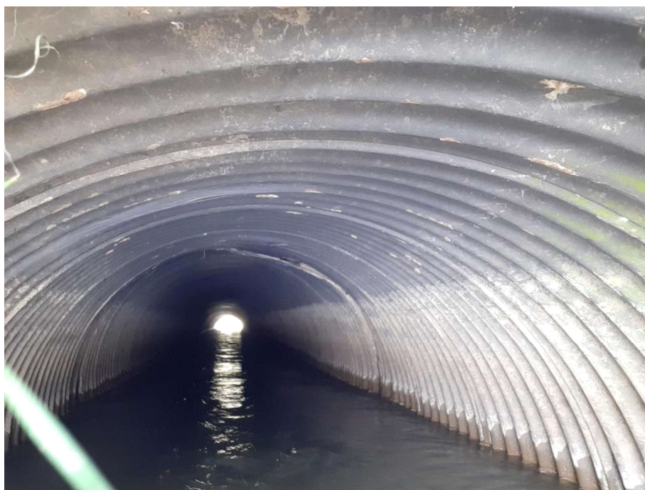
Figuur 4.6: binnenzijde duiker vanaf de zuidzijde
