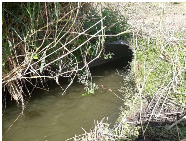
Figuur 4.2: Duiker ingang zuidzijde
