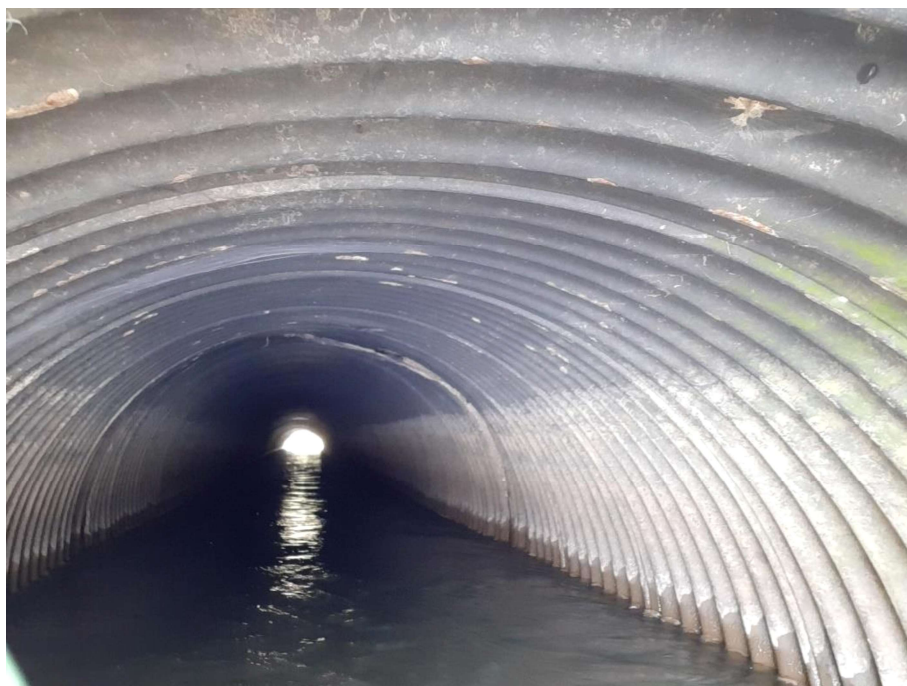
Figuur 4.5: binnenzijde duiker vanaf de zuidzijde
