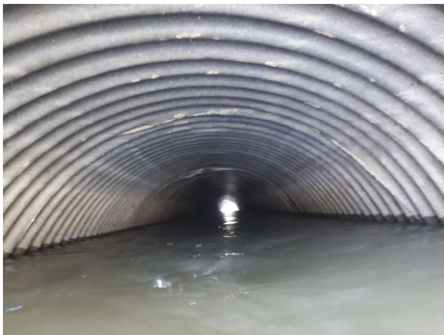
Figuur 4.4: binnenzijde duiker vanaf de noordzijde
