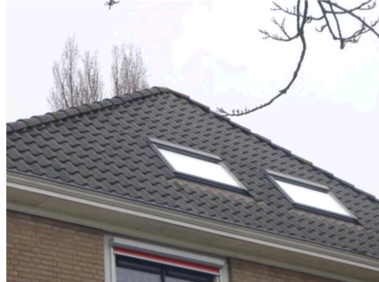
Figuur 2-3: Punt dakconstructie met pannen.
