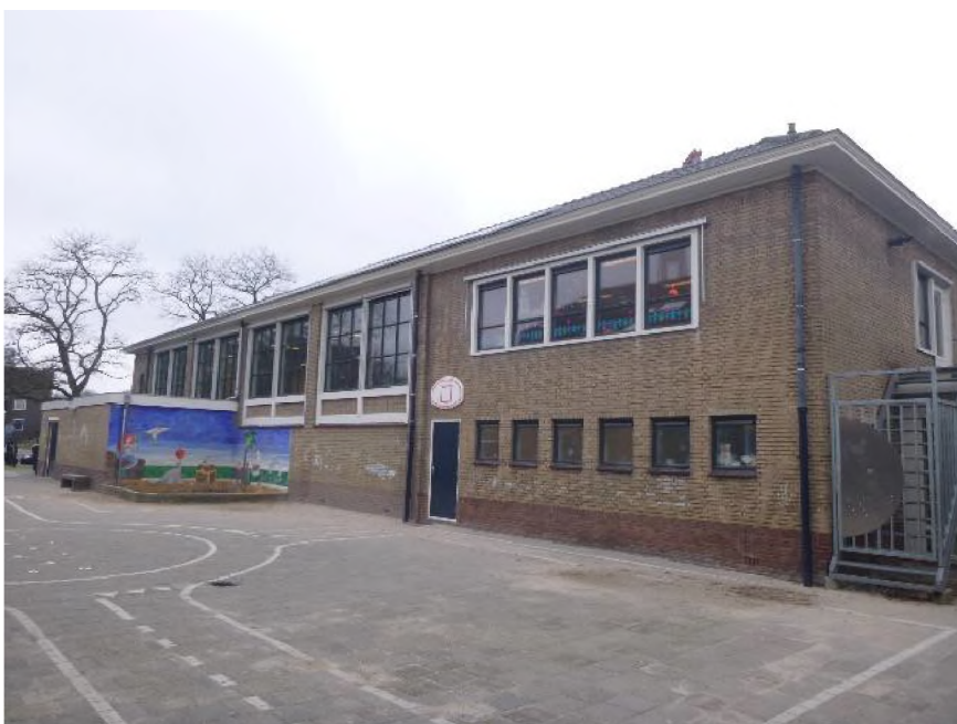
Fig. 3.1 Foto bestaande situatie
