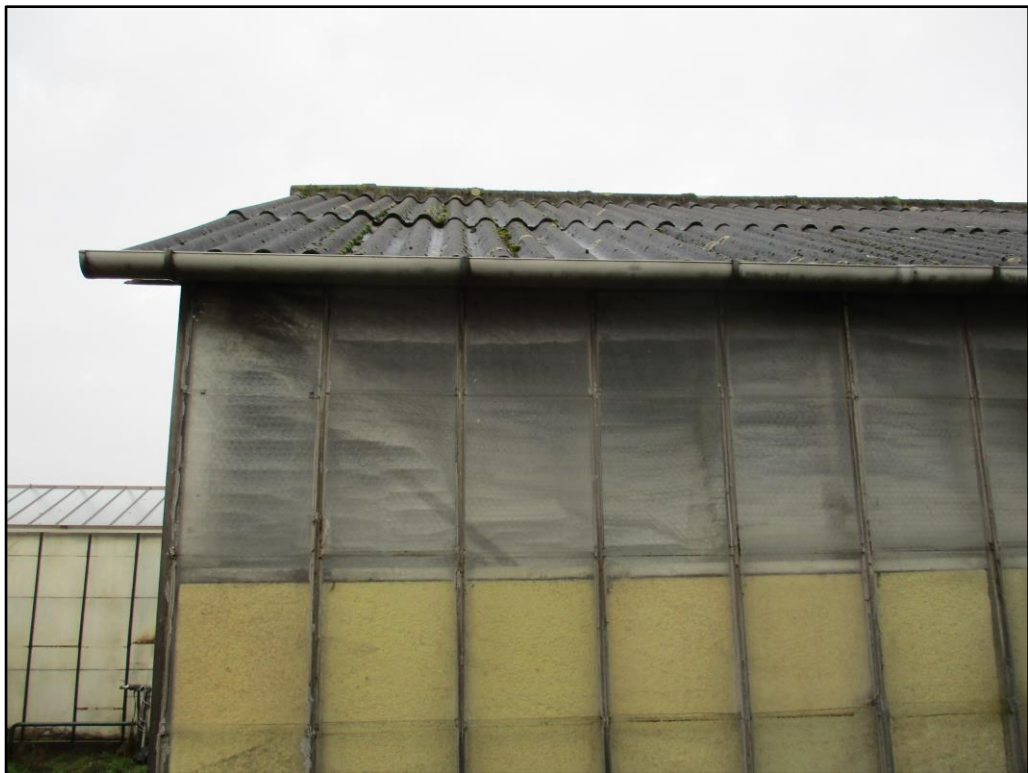
Figuur 4 De gevel en het golfplaten dak van het bijgebouw.
