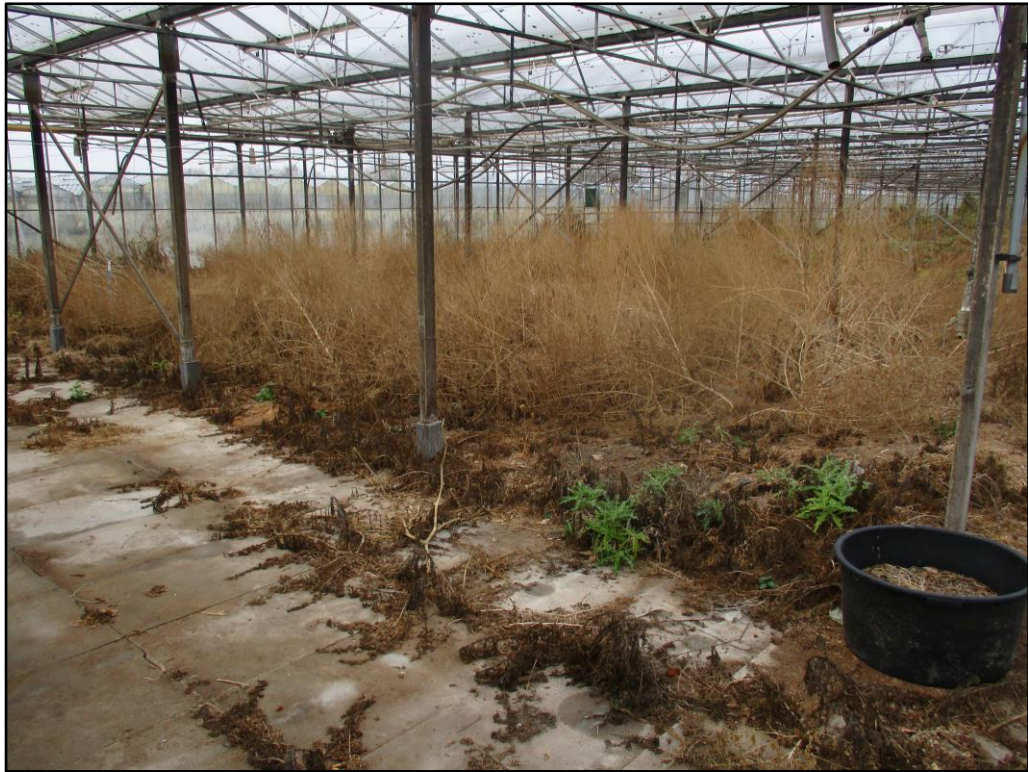
Figuur 3 Binnenzijde van de te saneren kas.
