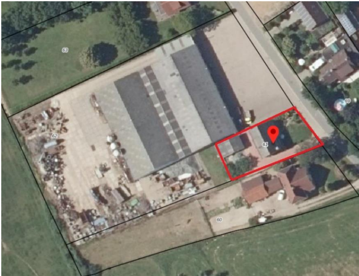
Afbeelding 2: Luchtfoto van het plangebied (bron: ruimtelijke plannen)
