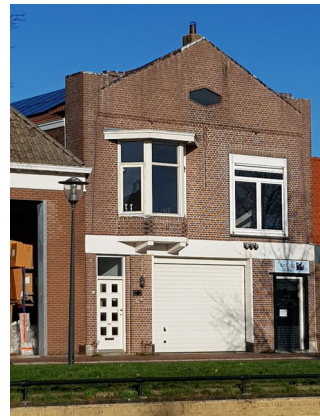
Zonnepanelen in beschermd gezicht Sneek
