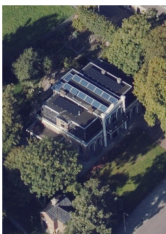
Zonnepanelen op een rijksmonument in Arum
