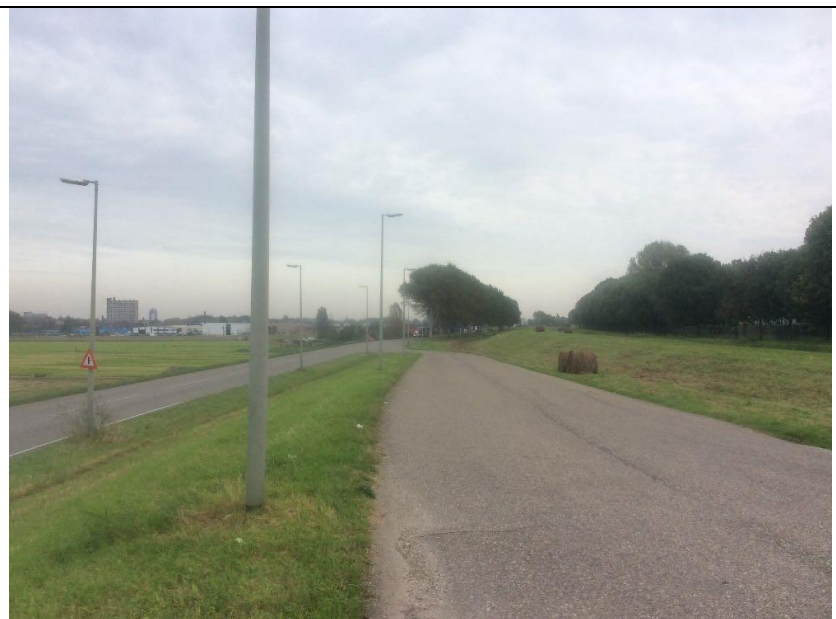
6. Afvoersloot (C) in oostelijke richting ter hoogte oprit Deltapad
