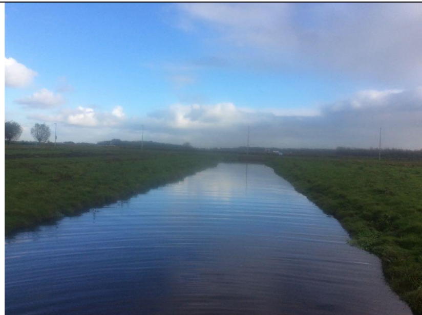
2. Watergang Spoorzone (B) in noordelijke richting
