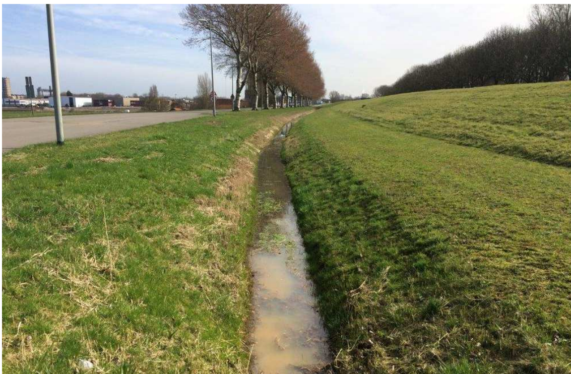
figuur 6: foto wegsloot Delflandse dijk met water (waterdiepte bedraagt ca. 30 cm)
