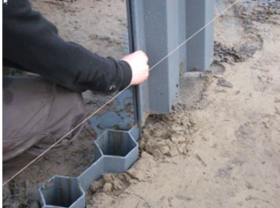
Figuur 9 Foto's aanbrengen kwelscherm
