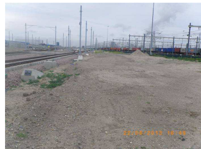
Foto 3: Bouwweg (halfverharding grind) op westelijke zijde van deellocaties A en B, gezien in noordelijke richting
