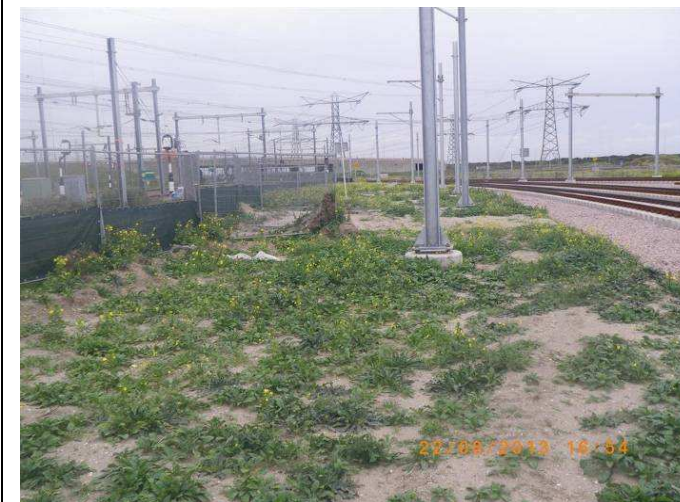
Foto 9: Zuidelijk deel van deellocatie C, gezien in zuidelijke richting
