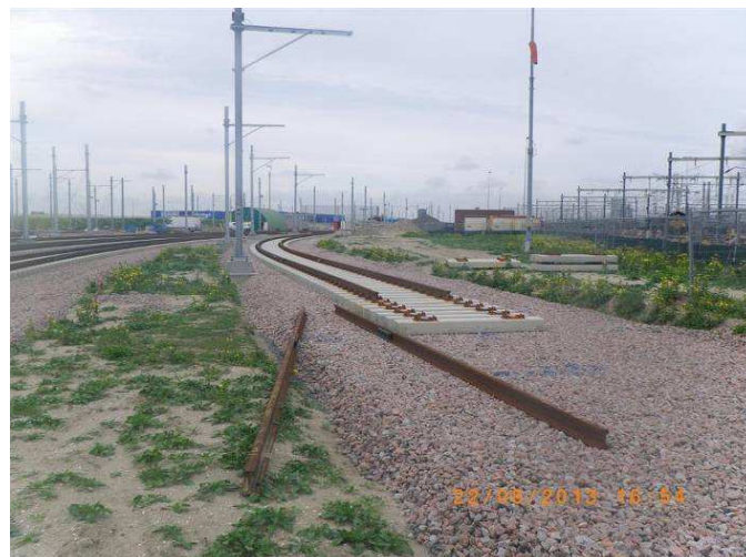
Foto 8: Recent gelegd spoor dat ten westen van deellocatie C ligt
