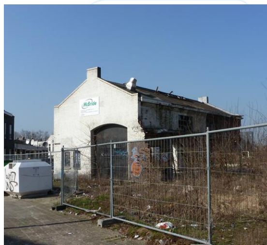
Figuur 6: 2019 restant gebouw McBride na sloop (Bron: Pinterest)
