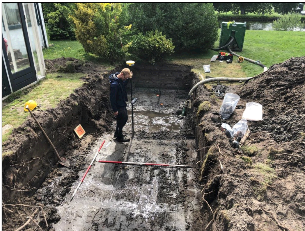
Figuur 2. Werkput 1 vlak 1: het inmeten van het vlak.
