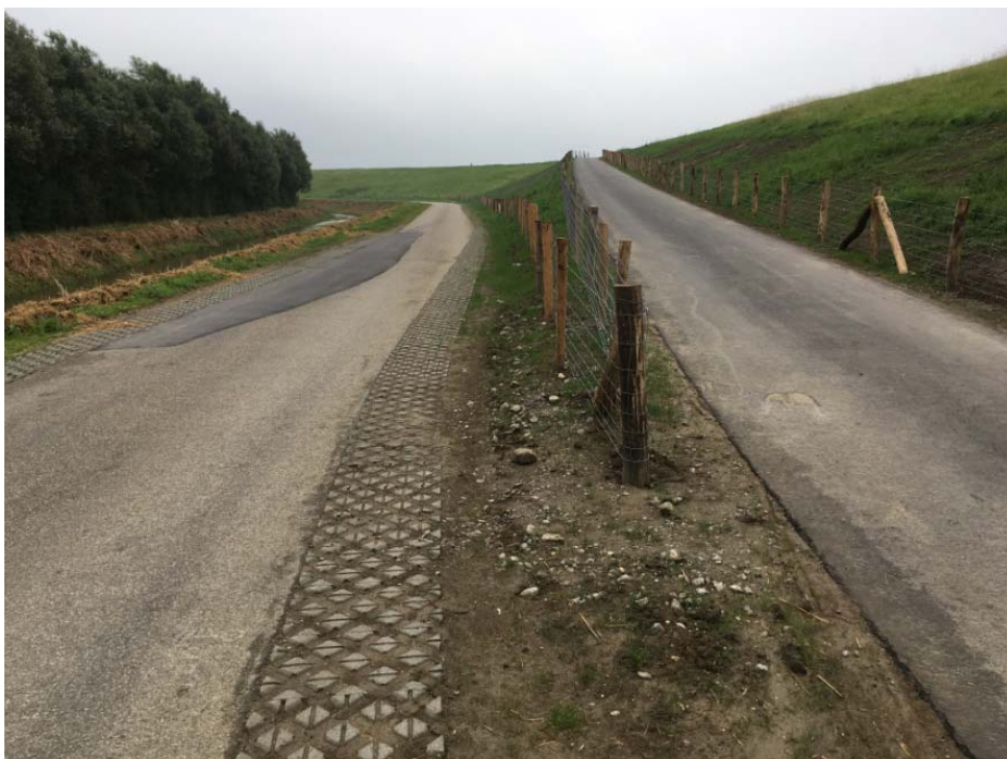
Figuur 3-3. Foto dijkovergang Biezelingse Ham in 's Gravenpolder
