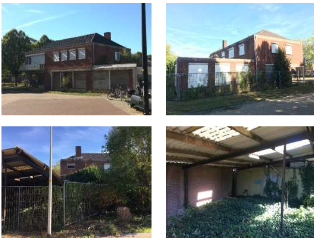
Figuur 3 Foto impressie van het plangebied op 26 september 2018. Linksboven een foto van de noord- en oostkant van het plangebied. Rechtsboven een foto van de zuidkant van het plangebied. Linksonder een foto van de westkant van het plangebied, met verruigde tuin en schuur. Rechtsonder een foto van de binnenkant van de schuur.
