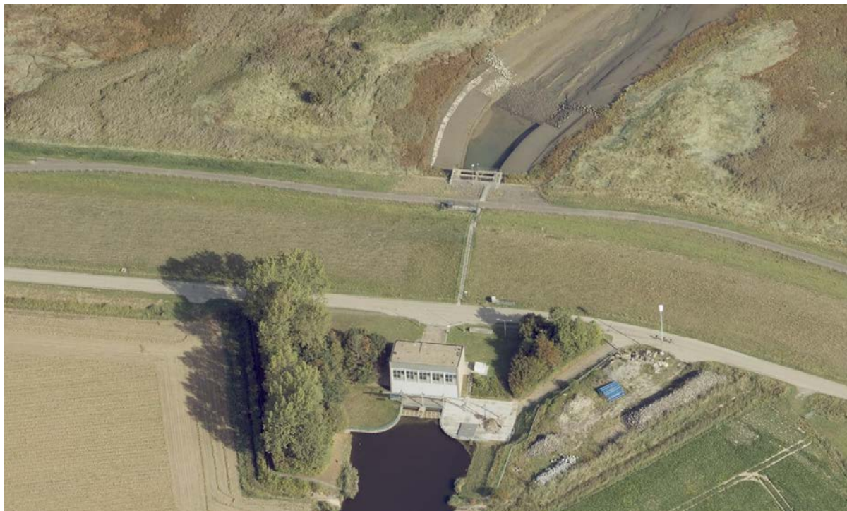
Figuur 6: Gemaal Paal, gezien vanuit de lucht (bron: Cyclomedia)
