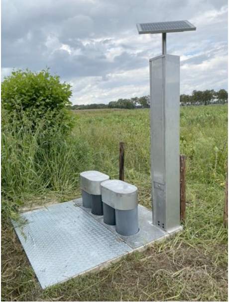
Put met Promeco toevoerregelingen en zuil met electr. componenten
