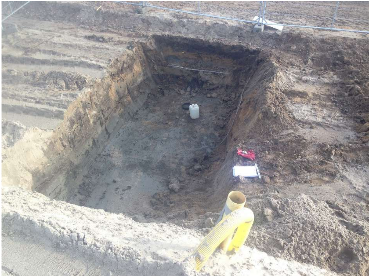
Foto 1: Ontgraving fietsenstalling Oost.
