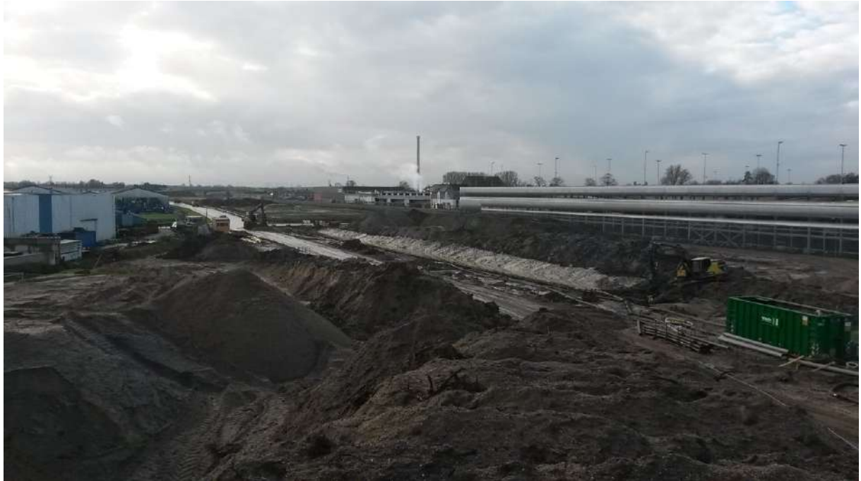
Foto 3: Ontgraven nieuwe watergang Zuidzijde
