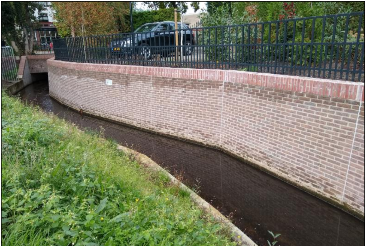
Figuur 16: voorbeeld grondkerende constructie (kademuur)
