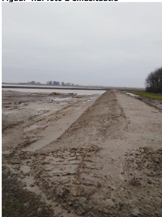
Figuur 4.2: foto 2 eindsituatie
