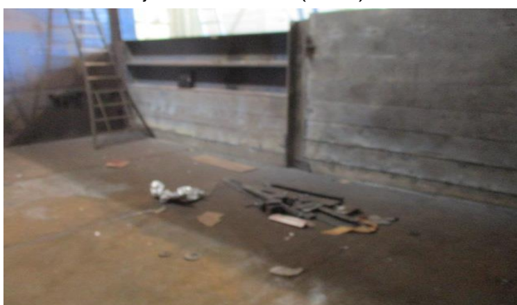
Aanzicht binnenzijde draaiselbunker ( 38 m 2 )
