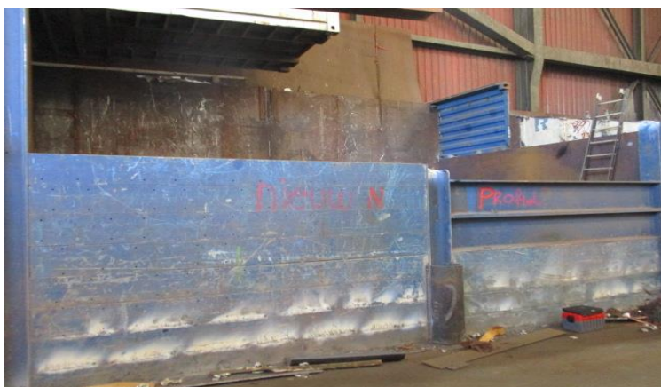
Aanzicht buitenzijde draaiselbunker ( 38 m 2 )
